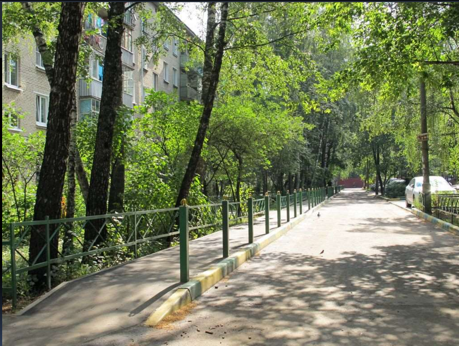
Придомовая территория Толстого, 7 после ремонта
